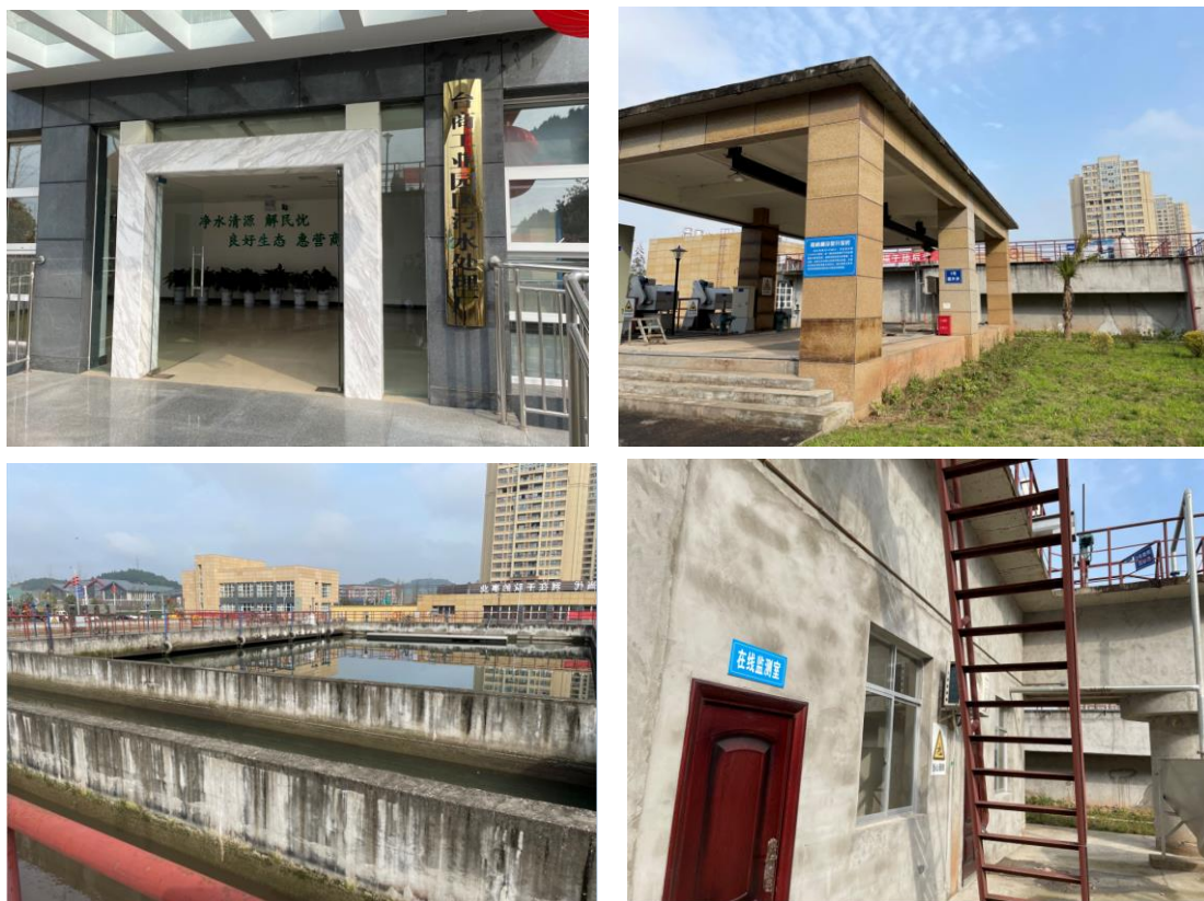
图 3.4-2 台商工业园污水处理厂一期工程现场照片
